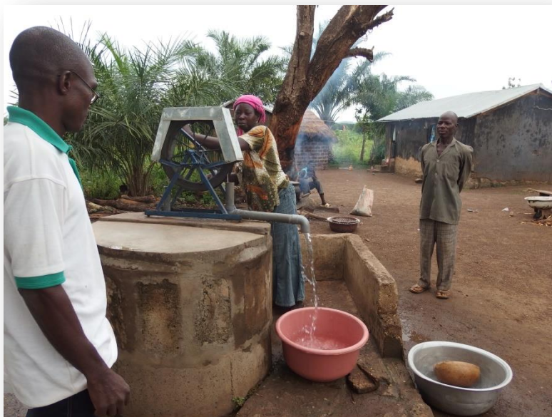
Een touwpomp in Sotouboua pompt het water op uit de put (veel hygiënischer dan zelf met touw en emmer water putten). De Stichting Victoriepompen financiert 20 touwpompen in Sotouboua, wij doen de organisatie van dit project.
