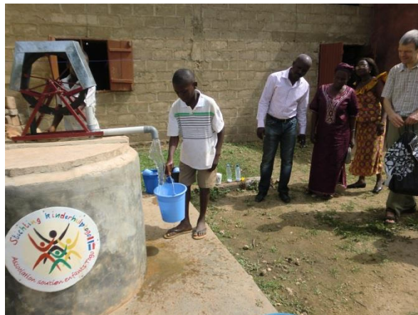
Inspectie van de waterput met touwpomp op de basisschool Christ-Roi.
