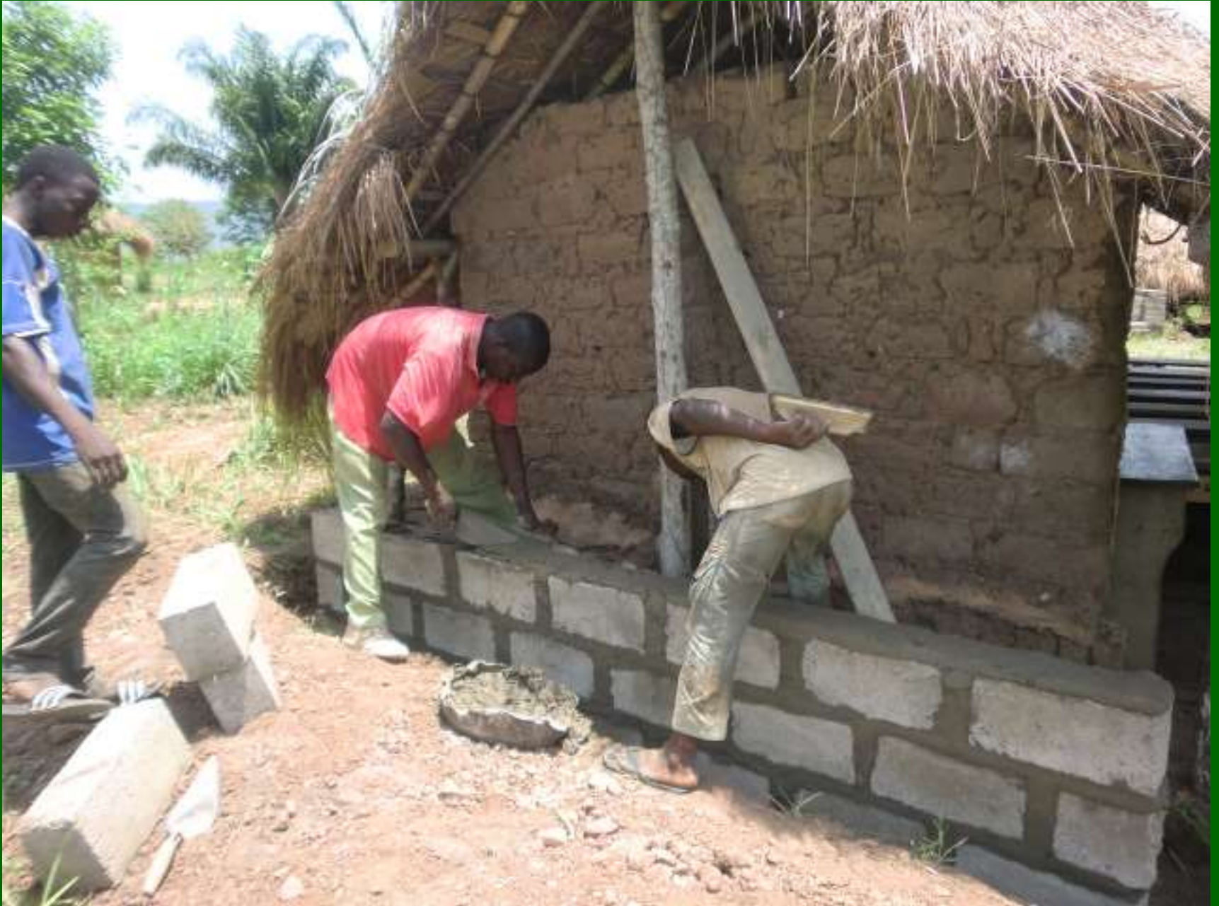
Muurtje metselen om schoolbord op te hangen
