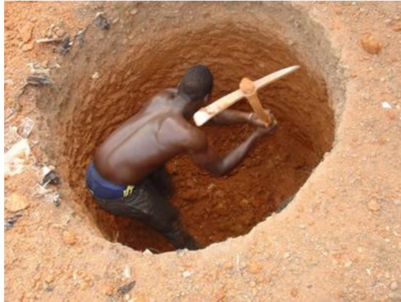
Waterputten worden in Togo met de hand gemaakt, soms tot 60 meter diep
