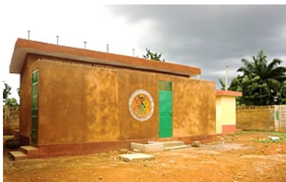
Les nouvelles toilettes de Tshinu ainsi que les toilettes rénovées.
