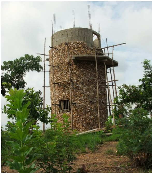
De bouw van de watertoren in de Lumen Valley vordert gestaag.
