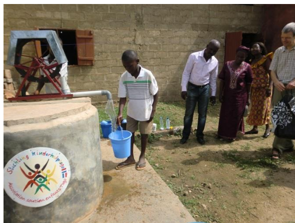
Inspection du puits (avec pompe à corde) à l'école primaire Christ-Roi.
